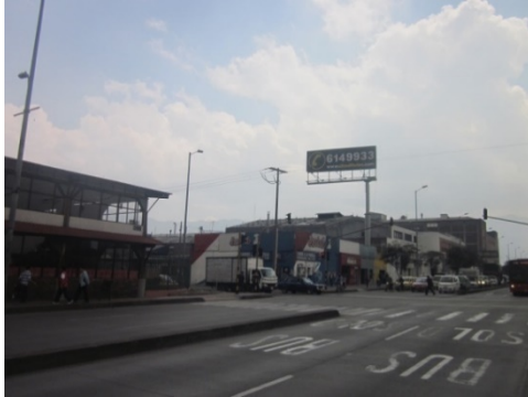
Foto No 1. Vista Panorámica OCC - OR
